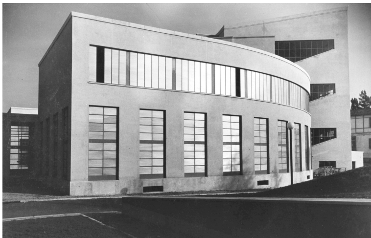
Figura 12. – Vista laterale dell'edificio (APM).
