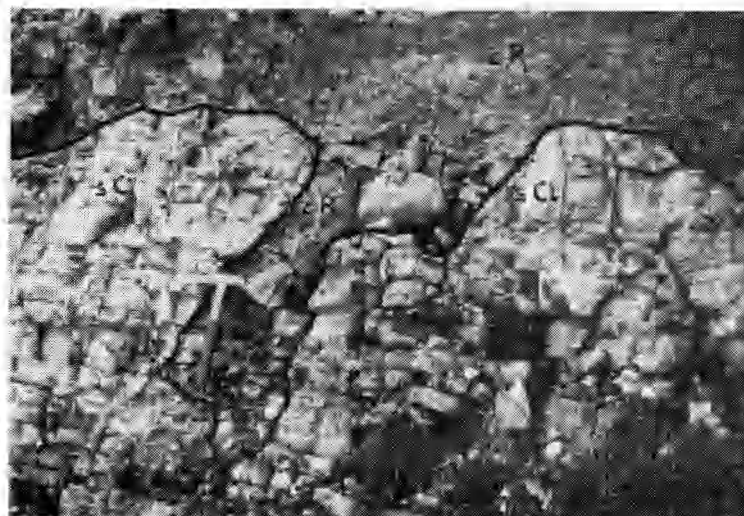
Fig. 2. – Idem come sopra; visto di fronte.
